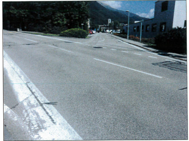
Innesto Via San Pietro su Via Cantonale
